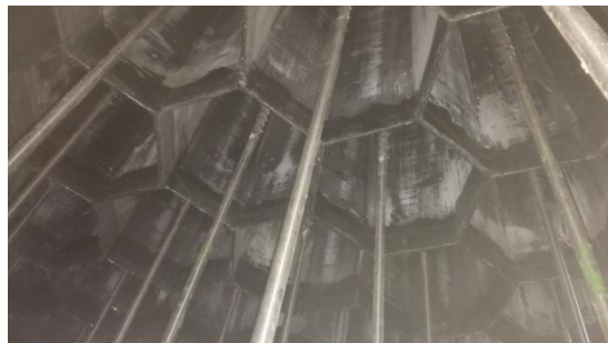
刚性阴极线安装后
