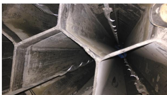
柔性阴极线安装后
